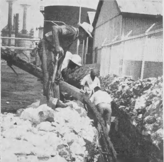
TRAHADORNAN TA pone canaster di hero den un sanja banda di Powerhouse No. 1 pa conducto di cable pa transformer, y despues nan ta basha concreto. Por-tretnan ariba ta muntra un vista general.
